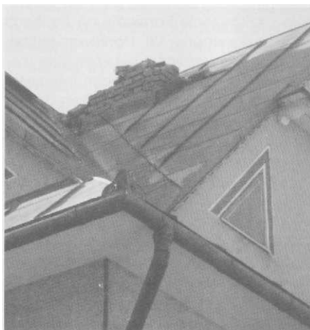
Rys. 11. Skrzypne – uszkodzone szyby w oknach kościoła (po trzęsieniu ziemi)
