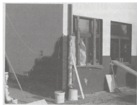
Rys. 7. Skrzypne – prace remontowe w budynku Zespołu Szkoły Podstawowej i Gimnazjum
